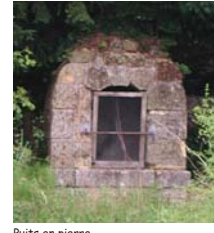
Puits en pierre
