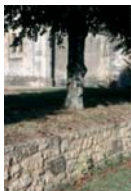
Tilleul et muret de soutènement en moellons de pierre
