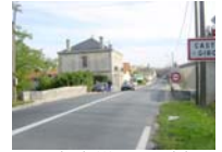
La nationale 113 traversant le bourg de Castres sur Gironde au niveau du Gât Mort
