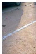
Parking en béton désactivé et calcaire
