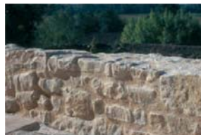
Muret en moellons de pierre
