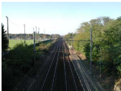
La coupure de la voie ferrée, également une façade paysagère pour le territoire.
