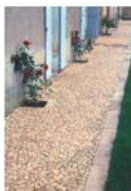
Trottoir en béton désactivé et calcaire
